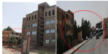
Fig. 6. L'installation d'un équipement public et d'une gare routière intercommunale dans la cité El-Amel-Biskra. Source: Auteurs, 2017
