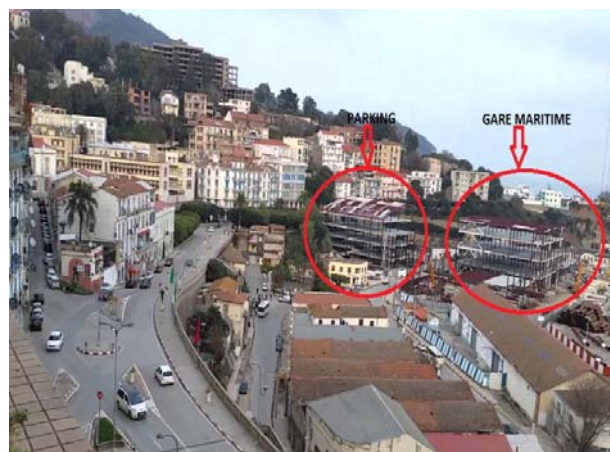
Fig. 12. Gare maritime et son parking en cours de construction
