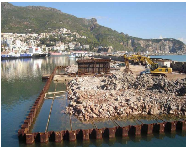
Fig. 8. Travaux d'extension du port de pêche
