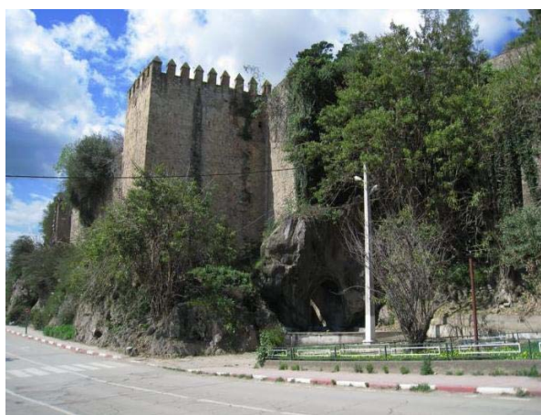
Fig. 4. Rempart Nord de la Casbah de Béjaia
