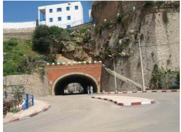
Fig. 9. Tunnel de Sidi Abdelkader réhabilité
