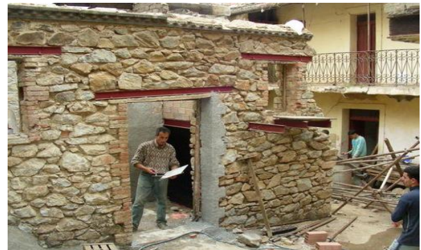
Fig. 13. Rénovation d'une maison kabyle.
