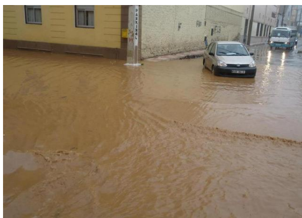
Fig. 2. Inondation de la gare routière.
