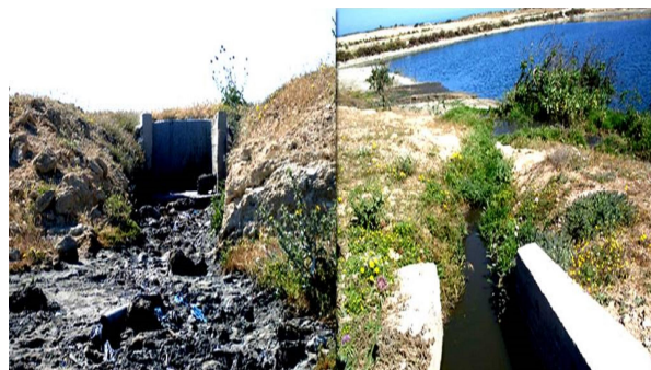
Fig. 3. Bassins de décantation de Cap Falcon. Source: Auteurs, 2015
