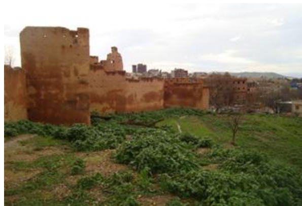
Fig. 9. Espaces extérieurs après les travaux. Source: Auteurs, 2016
