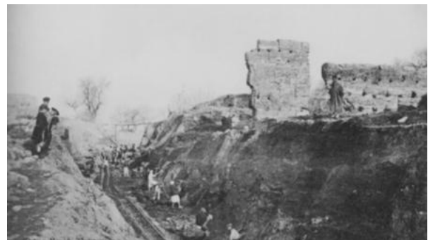
Fig. 8. Passage du chemin de fer à travers le site de Bâb El Quarmadine. Source: Archives Mairie de Tlemcen
