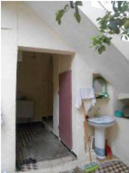
Fig. 18. Lave main sous la paillasse de l'escalier dans Dar Allem dans l'ancien centre de Nédroma (Auteurs, 2014)
