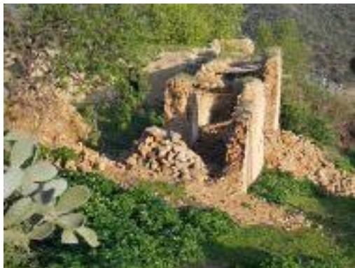
Fig. 6. Vue générale sur Dar El-Moudan (Auteurs, 2012)
