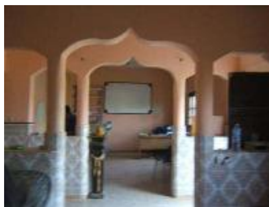
Fig. 18. Hall qui reprend certains éléments de l'architecture traditionnelle (colonnes et arcs de la cour traditionnelle) (Hadj-Kandouz, 2013)
