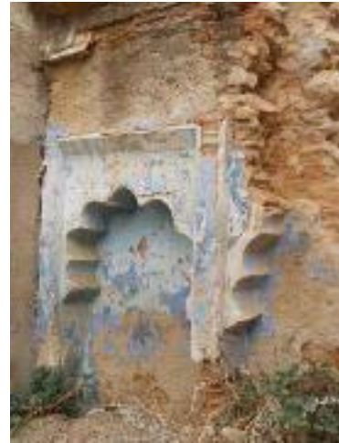
Fig. 11. Une partie d'un arc polylobé d'une niche dans un mur d'une habitation en ruine (Auteurs, 2013)
