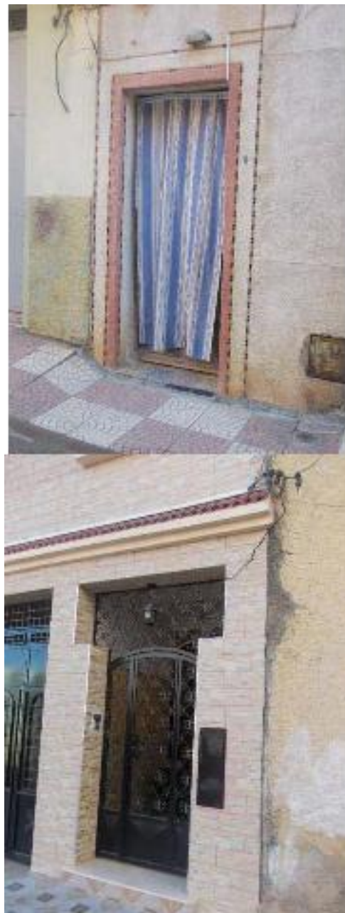
Fig. 24. Nouveaux dispositifs pour remédier au problème d'intimité (Auteurs, 2013)
