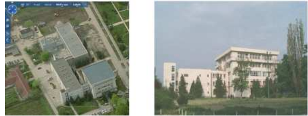
Fig. 2 Immeuble de la Faculté d'Améliorations Foncières et de l'Ingénierie de l'Environnement
