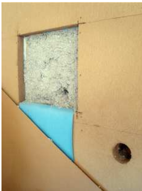
Fig. 10. Sistem de izolații realizate din materiale reciclate: fulgi de celuloză și plăci din fibre de lemn moale. (2010) Sursa imaginilor: arhiva personală arhitect Sergiu Petrea.
