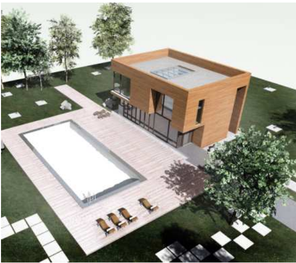
Fig. 14. Utilizarea unui spațiu central la o locuință, acoperit cu un luminator, pentru a obține o ventilare naturală pe timpul verii prin deschiderea controlată a golurilor din fațadă și a trapelor din acoperiș. Proiect aflat în avizare. Sursa imaginilor: arhiva personală arhitect Sergiu Petrea.
