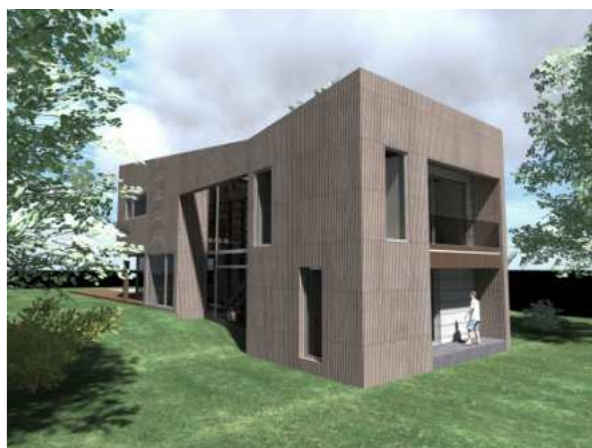
Fig. 13. Utilizarea spațiilor de tranziție pentru evitarea supraîncălzirii pe timp de vară și a serei centrale în cadrul unei locuințe în sistem pasiv din Suceava. Proiect aflat în execuție. Sursa imaginilor: arhiva personală arhitect Sergiu Petrea.
