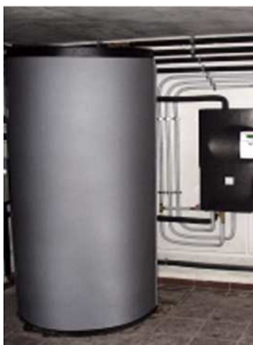
Fig. 6. Utilizarea unui stocator de la o locuință unifamilială care produce o economisire a resurselor energetice clasice de consum de până la 80%. (2009) Sursa imaginilor: arhiva personală arhitect Sergiu Petrea.
