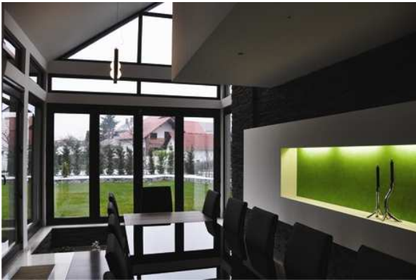
Fig. 14. Utilizarea unei sere dezvoltate pe două niveluri și a masei termice (perete din blocuri ceramice, placate cu piatră și pardoseală din piatră naturală peste o șapă cu dimensiune mai mare) în cadrul unei locuințe în din Rădăuți cu scopul de a obține un supliment termic la interior. (2007) Sursa imaginilor: arhiva personală arhitect Sergiu Petrea.
