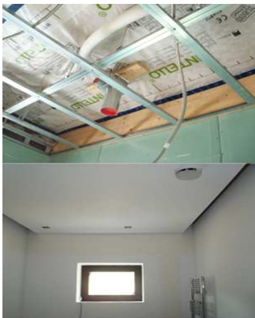
Fig. 4 Utilizarea unui sistem de ventilație cu recuperare de căldură – imagini din timpul montajului și imagine finală. Randamentul realizat practic al sistemului este de 84 % în timp de iarnă. (2011) Sursa imaginilor: arhiva personală arhitect Sergiu Petrea.
