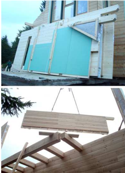
Fig. 3. Locuință de vacanță în Sucevița, Jud. Suceava (2008). Autori: Arh. Sergiu Petrea, arh. Cristina Petrea. Imagini ilustrând utilizarea unui sistem performant de închideri, complet prefabricat pentru o construcție cu consum energetic redus. Sursa imaginilor: arhiva personală arhitect Sergiu Petrea.
