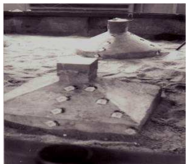
Fig. 4. Fundații din plăci subțiri conice și poliedrice
