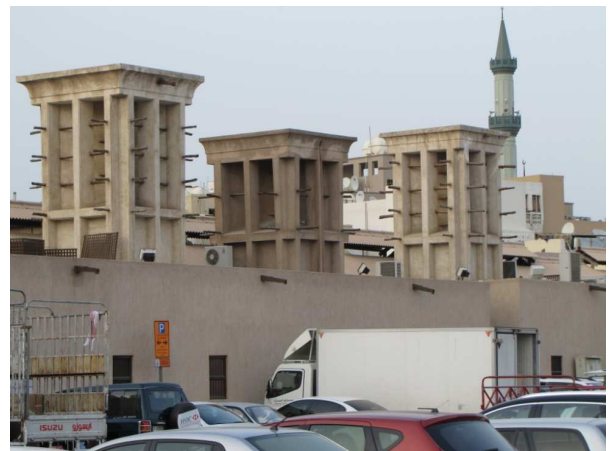
Fig. 1. Turnurile de vânt cu care sunt dotate locuințele tradiționale din Dubai
