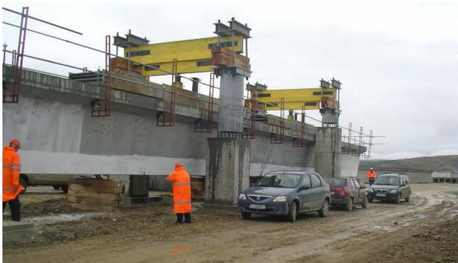
Fig. 6. Standul de încercări cu grinda U 37, înaintea testului de rezistență
