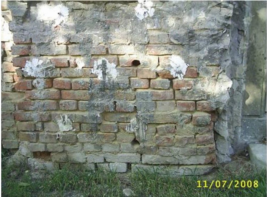
Fig. 11. Puncte de extracție probe și injecție soluție - perete exterior Sud - la nivelul solului (vertical cota 0.65 m de la cota 0 a solului și 0.9 m orizontal față de ușa 2, perete exterior Sud).
