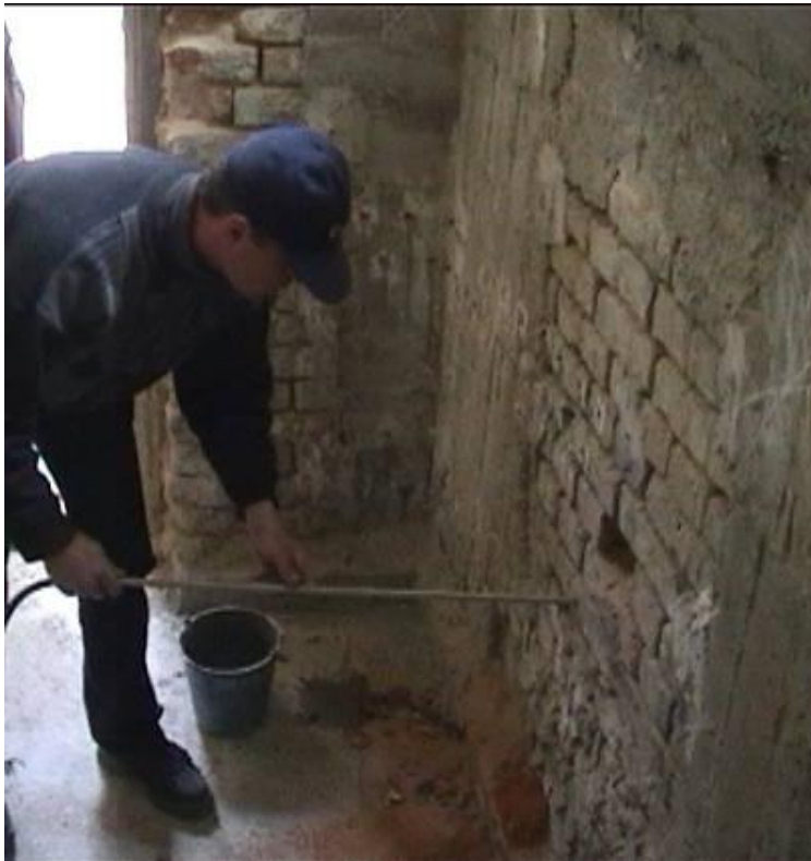
Fig. 15. Injectare soluție sub un unghi de 15° într-o încăpere interioară. Alimentarea dispozitivelor de injectare cu soluție până la saturarea zidului tratat.
