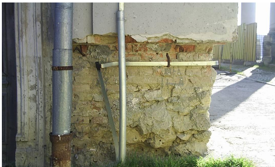
Fig. 10. Puncte de extracție probe și injecție soluție - perete exterior Nord colț cu perete exterior Vest - la nivelul solului și vertical până la cota 0.65 m și 0...1.,4 m orizontal față de ușa 1 - Parchet, Loge
