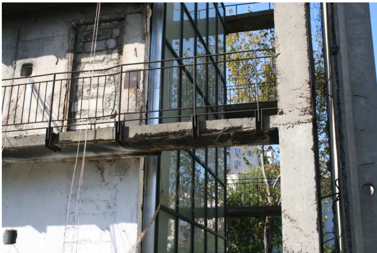
Fig. 3. Vedere de ansamblu a fațadei testate
