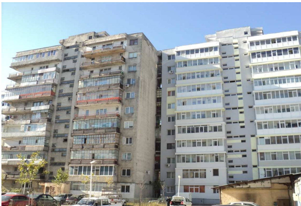
Fig. 1. Imagine comparativă Bloc GA15C, scara A, reabilitată termic și scara B nereabilitată termic, Municipiul Slatina, Strada Libertății, nr. 12
