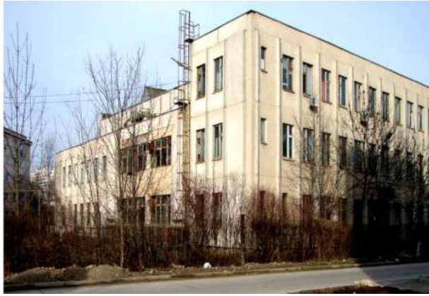
Fig. 5. Clădirea Laboratorului de cercetări Obiectiv 101- Podu Roș, Laborator IH, Iași –str. Prof. Anton Șesan 37. - vedere de ansamblu
