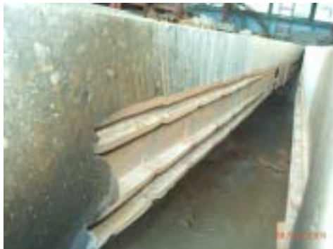
Fig. 16. Comportarea suprafețelor de contact dintre blocurile ceramice și stratul de beton din suprabetonare
