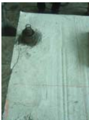
Fig. 14. Fisurarea zonei de prindere a centurilor planșeului
