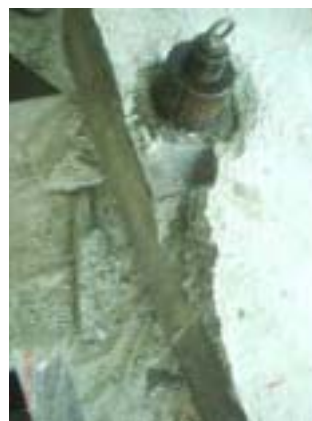
Fig. 14. Fisurarea zonei de prindere a centurilor planșeului
