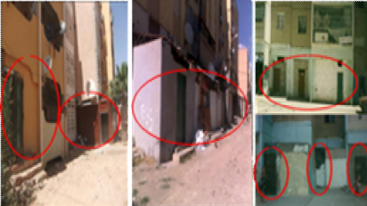
Fig. 8. De gauche à droite: Cité 400 logt-Ouargla, Cité 1006 logt-Sétif, Cité 500 logt- M'sila. Source: Auteurs, 2017
