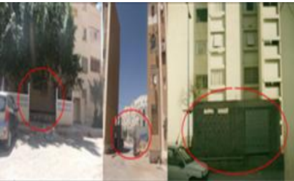
Fig. 9. De gauche à droite: Cité 824 logt-Biskra, Cité El-Naser-Ouargla, Cité 1200 logt- Batna. Source: Auteurs, 2017
